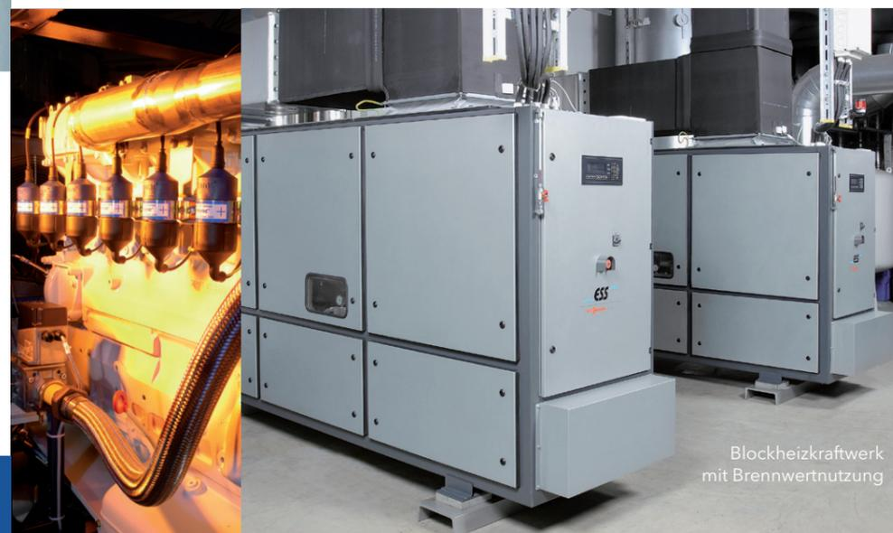
Blockheizkraftwerk mit Brennwertnutzung
